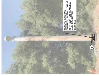
SNORKEL VALVE INSTALL DETAIL RINCON MAIN STA 357+80.2 1 N.T.S.
